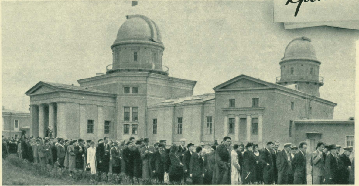
В день открытия Пулковской обсерватории. Гости осматривают главное здание и астрономические павильоны.
