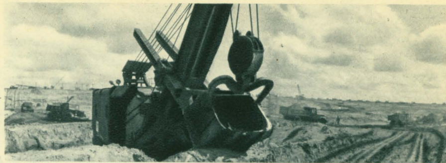
Разработка котлована для будущего здания гидроэлектростанции.
