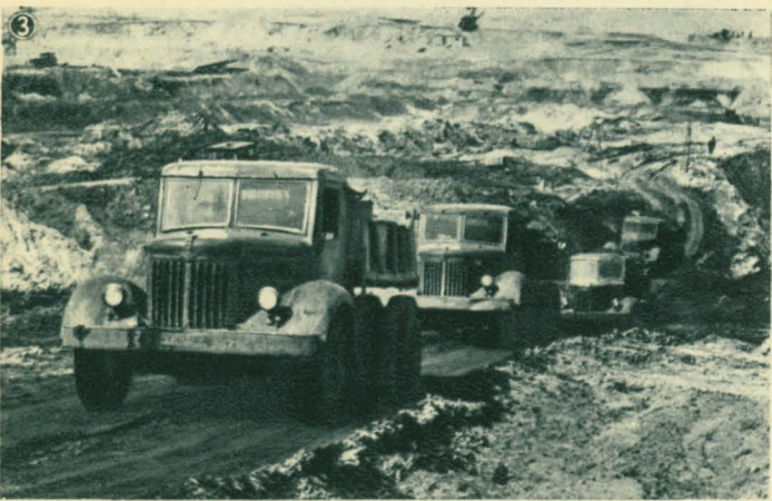
1. Более 100 километров железнодорожных путей проложено по площадке строительства. Сооружение этих дорог механизировано. 2. Технолог Светлана Кравец проверяет качество арматурно-сварочных работ. 3. Автомашины ежедневно вывозят из котлована тысячи тонн грунта.
